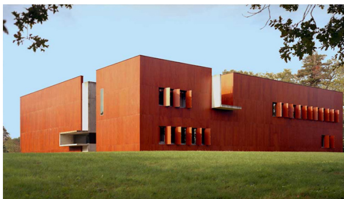
Batiment du Frac à Carquefou
